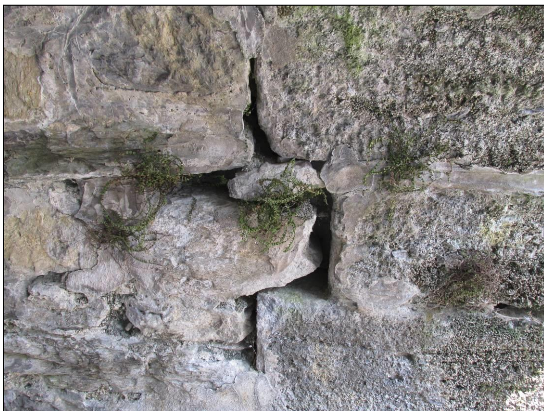
Obr. č. 10 - detail na zdivo u čela opěry - do hloubky zcela degradované pojivo, vypadané z konstrukce, ve spárách uchyceny rostliny
