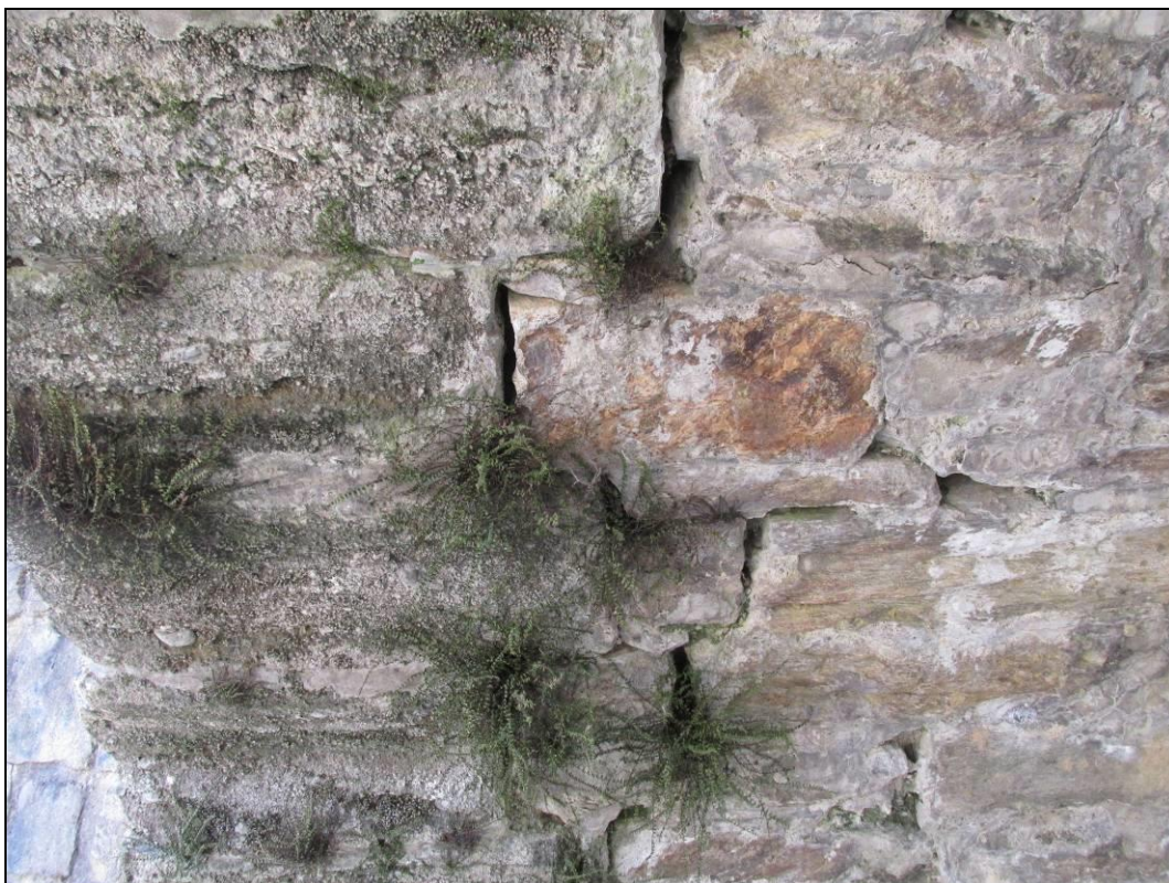
Obr. č. 9 - detail na zdivo u čela klenby - do hloubky zcela degradované pojivo, vypadané z konstrukce, ve spárách uchyceny rostliny
